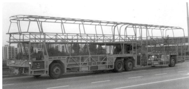
9 Struktura avtobusa je bila močno ojačana in prilagojena skupni teži 28 ton.
